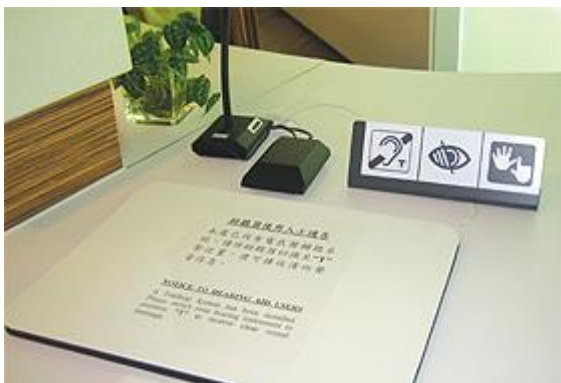
為聽障人士而設的電感圈輔聽系統。
